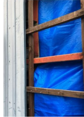
写真 15 壁面の胴縁(近景)
