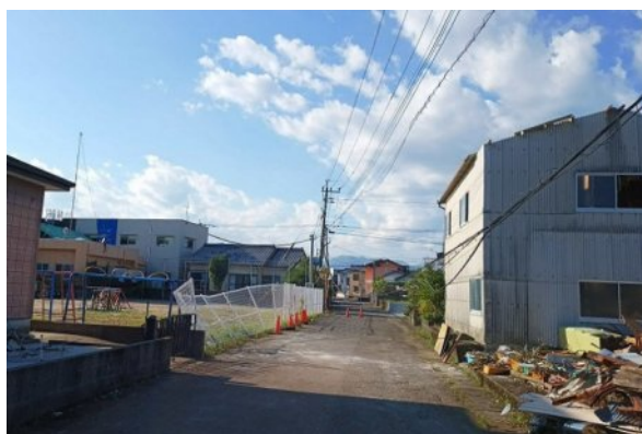
写真 19 倉庫(右)の倒壊に伴うフェンスの破損
