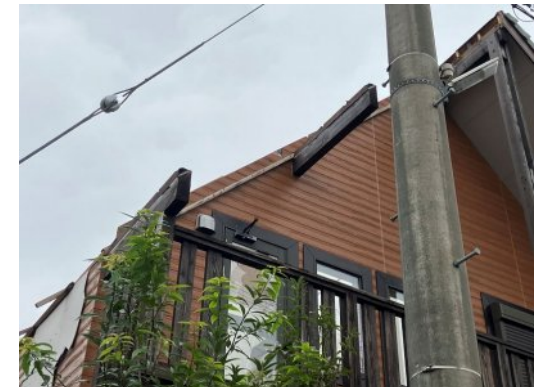
写真 8 屋根の損壊
