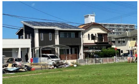
写真 6 隣接する建物の被害の違い
