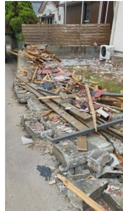
写真 12 倒壊ブロック塀(近景)
