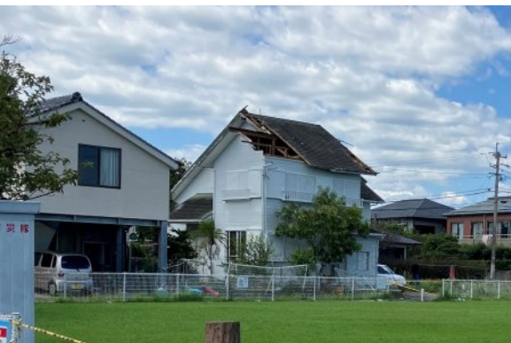
写真 7 野地板の飛散
