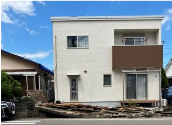
写真 11 ブロック塀の倒壊
